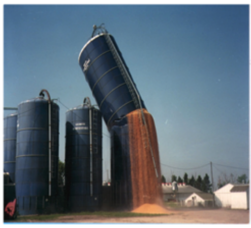
Figura 8. Rotura de un silo
